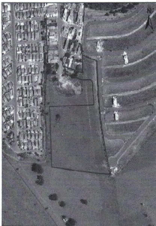
Foto 1 - Vista Aérea área 1B e 2B
