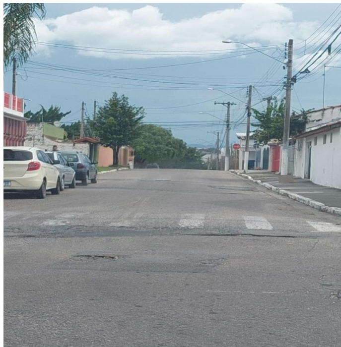
Rua Castro Alves, na altura do nº 145.
