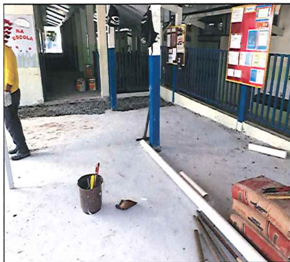
FOTO 09: VISTA DO PÁTIO DE ENTRADA, DURANTE A EXECUÇÃO DOS SERVIÇOS. 17/12/2019 - 09:12
