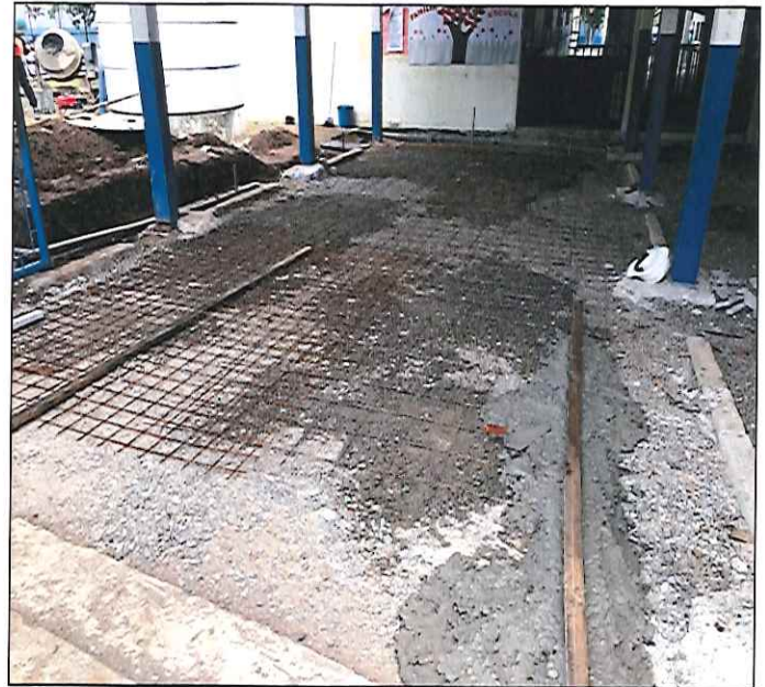
FOTO 06: VISTA DO PÁTIO DURANTE A EXECUÇÃO DO SERVIÇO. 04/12/2019 - 10:09
