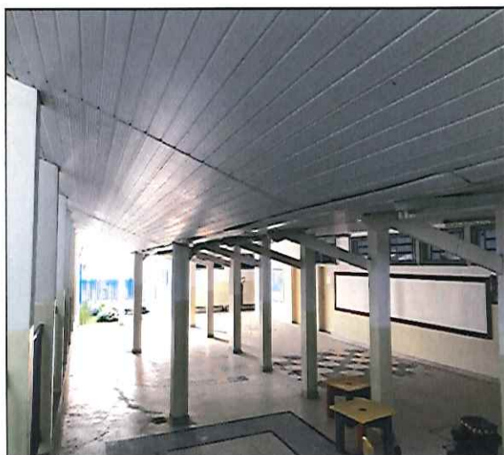
FOTO 01: VISTA DO PÁTIO COBERTO ANTES DA EXECUÇÃO DO SERVIÇO. 15/07/2019 - 15:30
