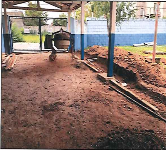
FOTO 05: VISTA DO PÁTIO DURANTE A EXECUÇÃO DO SERVIÇO. 04/12/2019 - 10:09
