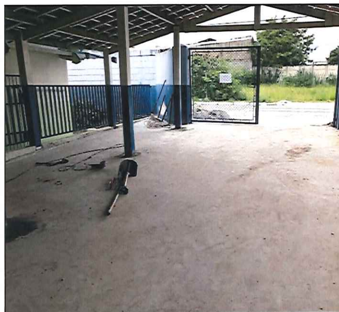
FOTO 10: VISTA DO PÁTIO DE ENTRADA FINALIZADO. 18/12/2019 - 15:35
