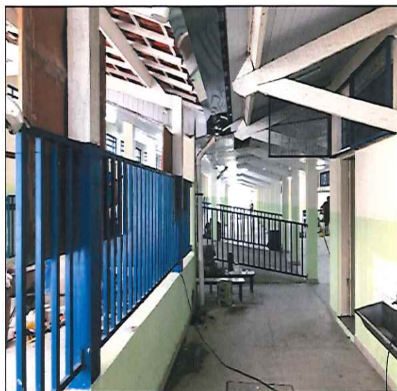
FOTO 11: VISTA DA CALHA FINALIZADA. 18/12/2019 - 15:38
