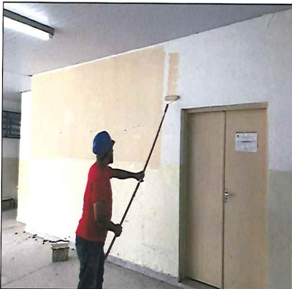
FOTO 07: VISTA DO PÁTIO COBERTO, DURANTE A EXECUÇÃO DO SERVIÇO. 12/12/2019 - 10:16
