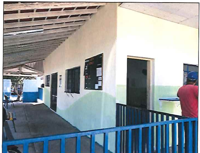
FOTO 08: VISTA DO PÁTIO COBERTO, DURANTE A EXECUÇÃO DOS SERVIÇOS. 17/12/2019 - 09:13
