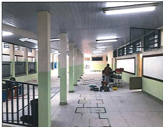
FOTO 12: VISTA DA PINTURA FINALIZADA. 18/12/2019 - 15:41
