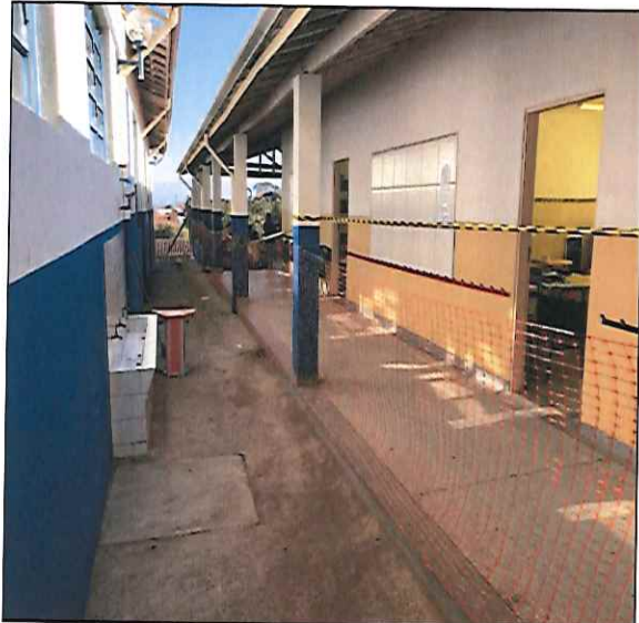
FOTO 11: VISTA DE PÁTIO ISOLADO DURANTE A EXECUÇÃO DOS SERVIÇOS. 09/08/2019 - 09:13
