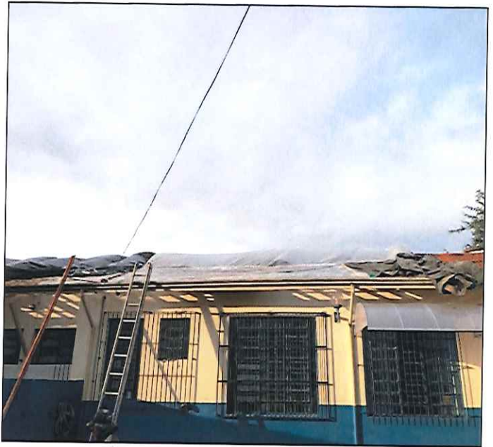
FOTO 10: VISTA DE COBERTURA DURANTE A EXECUÇÃO DO SERVIÇO. 05/08/2019 - 16:53
