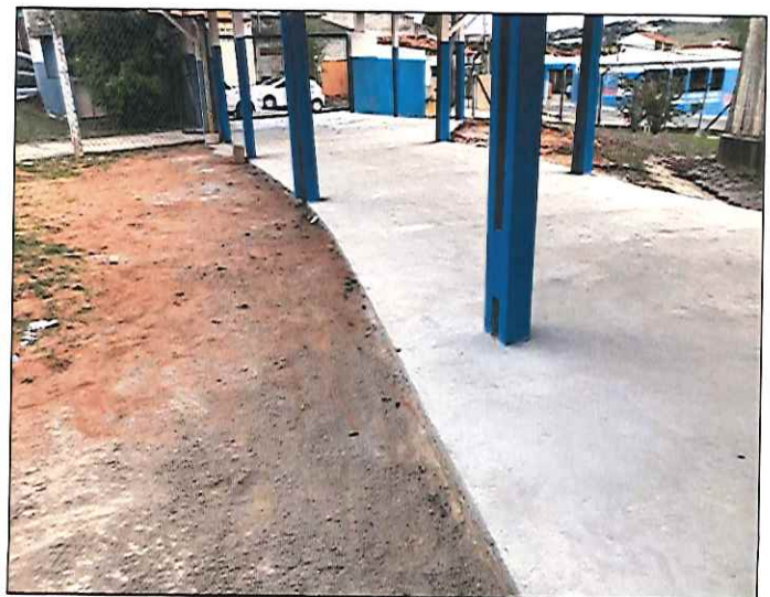
FOTO 16: VISTA DE PÁTIO DE ENTRADA FINALIZADO. 29/08/2019 - 14:38
