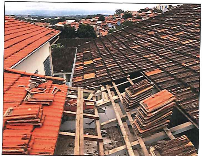
FOTO 12: VISTA DE PARTE DA COBERTURA ONDE HAVIA NECESSIDADE DE REDIMENSIONAMENTO DE CALHA. 06/08/2019 - 09:28
