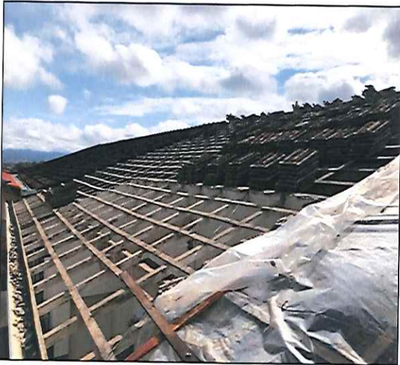
FOTO 09: VISTA DE COBERTURA DURANTE A EXECUÇÃO DO SERVIÇO. 05/08/2019 - 10:16
