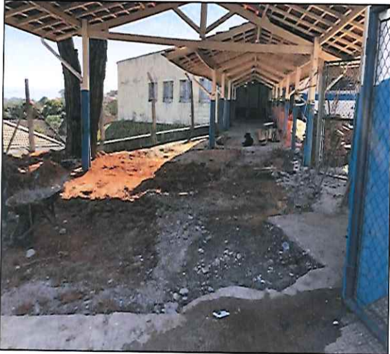
FOTO 13: VISTA DE PÁTIO DE ENTRADA DURANTE A EXECUÇÃO DO SERVIÇO. 12/08/2019 - 11:39
