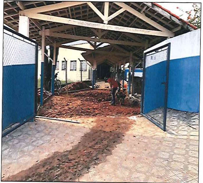
FOTO 14: VISTA DE PÁTIO DE ENTRADA DURANTE A EXECUÇÃO DO SERVIÇO. 13/08/2019 - 16:09
