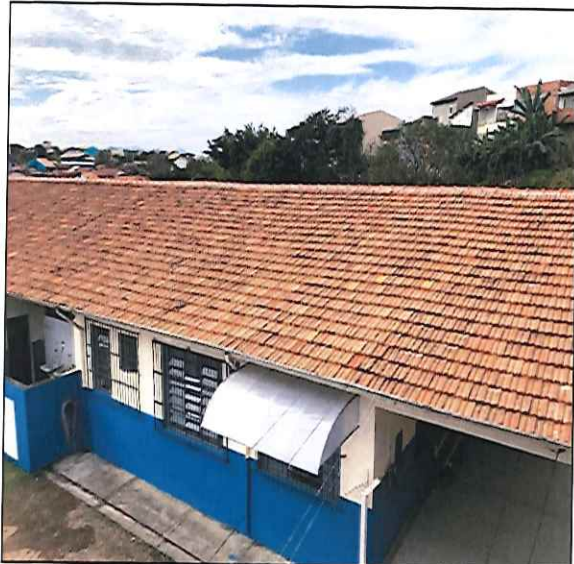
FOTO 15: VISTA DE SERVIÇOS DE COBERTURA FINALIZADOS. 29/08/2019 - 14:41
