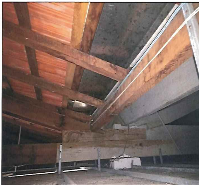
FOTO 02: VISTA DAS TESOURAS DO PÁTIO INTERNO. 21/03/2019 - 15:11
