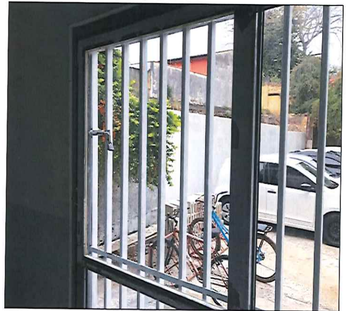
FOTO 10: VISTA DE VIDRO APÓS A EXECUÇÃO DOS SERVIÇOS. 28/08/2019 - 09:58
