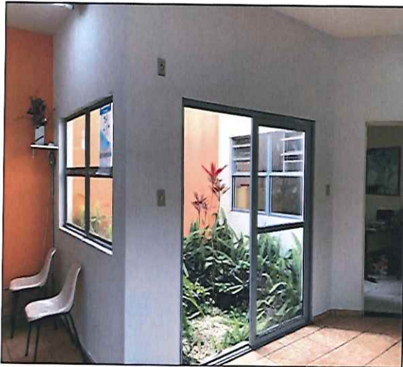
FOTO 09: VISTA DE PAREDE APÓS A EXECUÇÃO DO SERVIÇO. 28/08/2019 - 09:52
