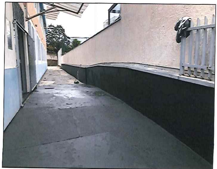
FOTO 12: VISTA DO MURO DE ENTRADA APÓS EXECUÇÃO DOS SERVIÇOS. 28/08/2019 - 09:54
