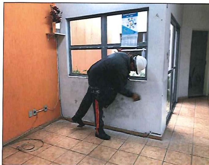
FOTO 08: VISTA DE PAREDE DURANTE A EXECUÇÃO DO SERVIÇO. 23/08/2019 - 09:43
