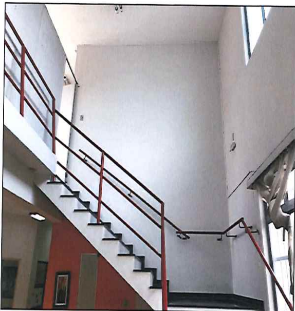
FOTO 11: VISTA DE PAREDE APÓS A EXECUÇÃO DOS SERVIÇOS. 28/08/2019 - 09:51
