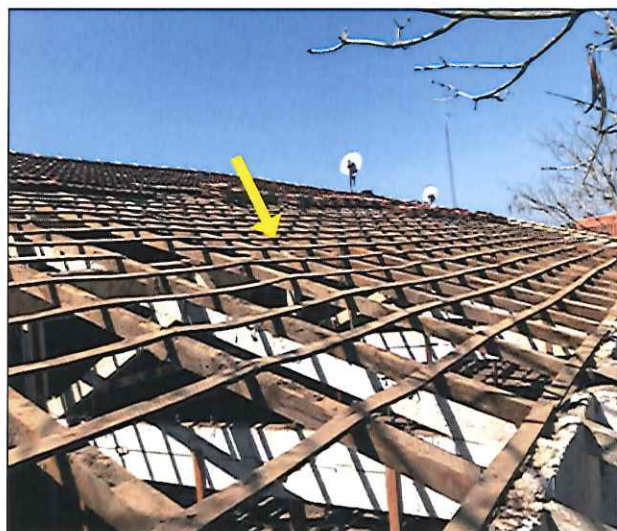
FOTO 10: VISTA DA COBERTURA DO TELHADO PRINCIPAL DURANTE A EXECUÇÃO DO SERVIÇO. 12/08/2019 - 10:35
