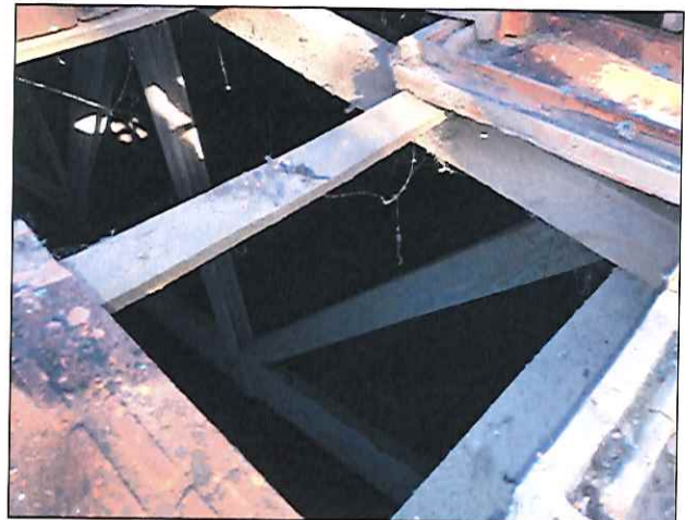
FOTO 04: VISTA DA ESTRUTURA DA COBERTURA. 30/07/2019 - 16:21
