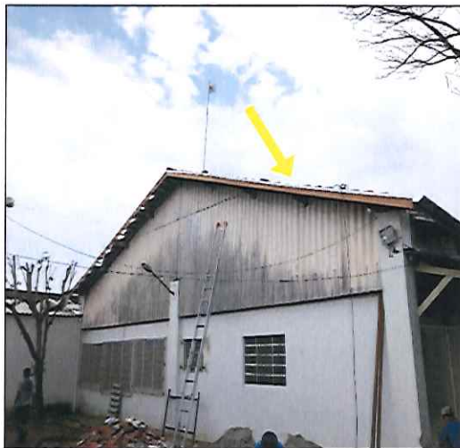
FOTO 11: VISTA DO BLOCO PRINCIPAL DURANTE A EXECUÇÃO DO SERVIÇO. 02/09/2019 - 11:39
