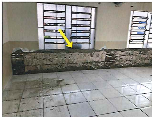
FOTO 12: VISTA DE PAREDE SENDO PREPARADA PARA EMASSAMENTO COM ARGAMASSA. 02/09/2019 - 11:25
