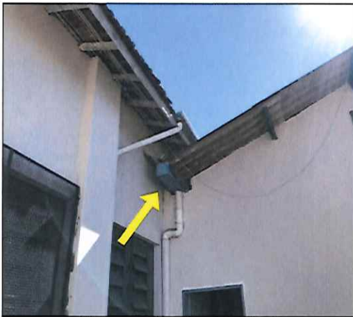
FOTO 05: VISTA DE CALHA ONDE HA A NECESSIDADE DE MANUTENÇÃO. 08/08/2019 - 10:44
