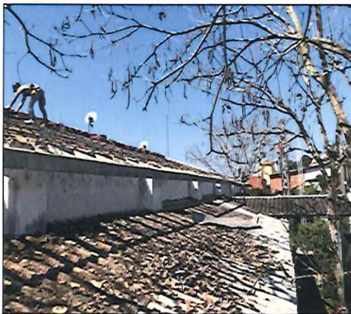
FOTO 09: VISTA DE COBERTURA DURANTE A EXECUÇÃO DO SERVIÇO. 12/08/2019 - 10:30
