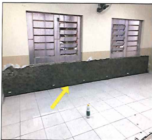
FOTO 13: VISTA DE PAREDE DURANTE A EXECUÇÃO DO SERVIÇO. 05/09/2019 - 16:30
