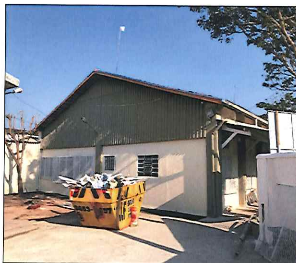
FOTO 14: VISTA DO BLOCO PRINCIPAL FINALIZADO. 16/09/2019 - 15:49
