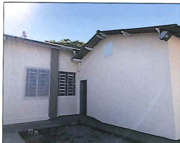
FOTO 16: VISTA DO BLOCO PRINCIPAL FINALIZADO. 04/10/2019 - 15:36
