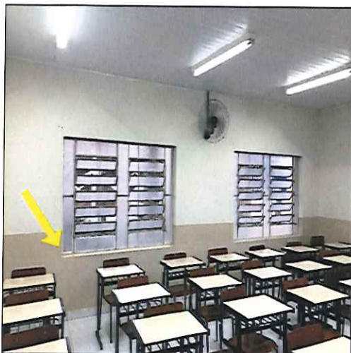
FOTO 15: VISTA DE PAREDE APÓS A EXECUÇÃO DO SERVIÇO, JÁ ACABADA. 23/09/2019 - 15:36
