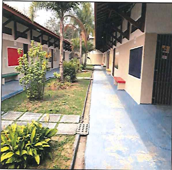
FOTO 03: VISTA DA ÁREA DAS SALAS DE AULA, ANTES DA EXECUÇÃO DO SERVIÇO. 19/09/2019 - 09:52
