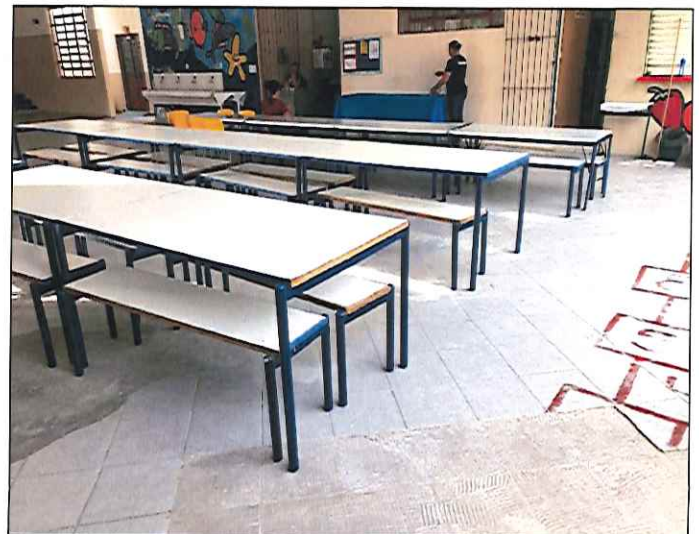
FOTO 08: VISTA DO LOCAL ONDE SE ENCONTRAVA O BANCO DE CONCRETO. 13/11/2019 - 16:34
