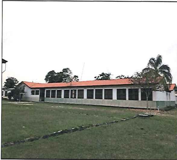
FOTO 05: VISTA GERAL DA EDIFICAÇÃO ANTES DA EXECUÇÃO DO SERVIÇO. 19/09/2019 - 10:06
