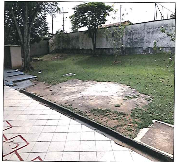
FOTO 02: VISTA DA ÁREA DEFRENTE AO PÁTIO COBERTO ANTES DA EXECUÇÃO DO SERVIÇO. 19/09/2019 - 09:40
