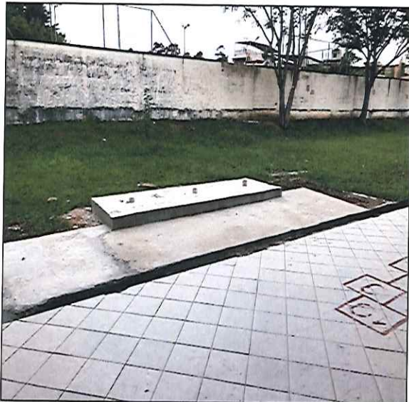
FOTO 11: VISTA DEFRENTE AO PÁTIO COBERTO, APÓS A EXECUÇÃO DO SERVIÇO. 25/11/2019 - 10:07
