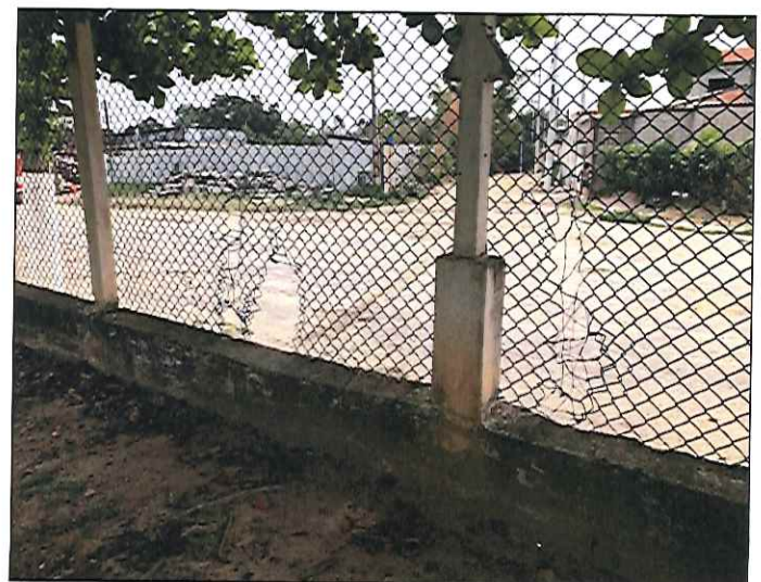
FOTO 04: VISTA DO ALAMBRADO ANTES DA EXECUÇÃO DO SERVIÇO. 19/12/2019 - 10:00
