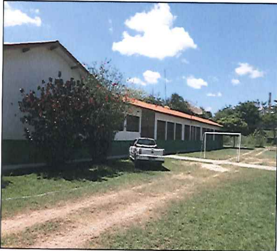
FOTO 09: VISTA GERAL DA EDIFICAÇÃO, APÓS A EXECUÇÃO DOS SERVIÇOS. 21/11/2019 - 15:04
