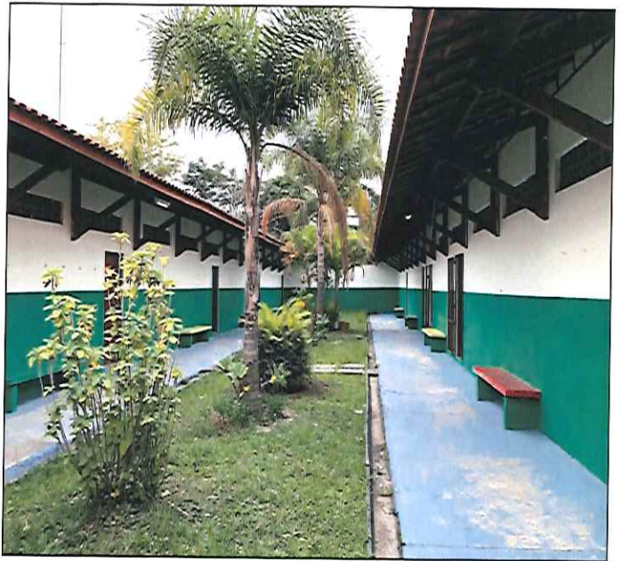
FOTO 10: VISTA DA ÁREA DAS SALAS DE AULA, APÓS A EXECUÇÃO DO SERVIÇO. 25/11/2019 - 09:48
