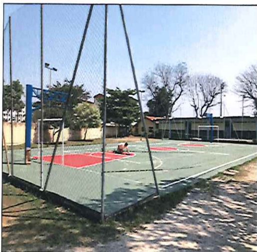
FOTO 11: VISTA DA QUADRA POLIESPORTIVA DURANTE A EXECUÇÃO DO SERVIÇO. 18/09/2019 - 10:37
