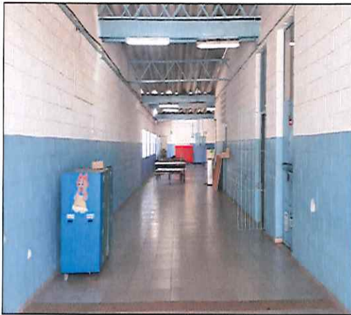
FOTO 01: VISTA DO REFEITORIO ANTES DA EXECUÇÃO DOS SERVIÇOS. 17/07/2019 - 12:04
