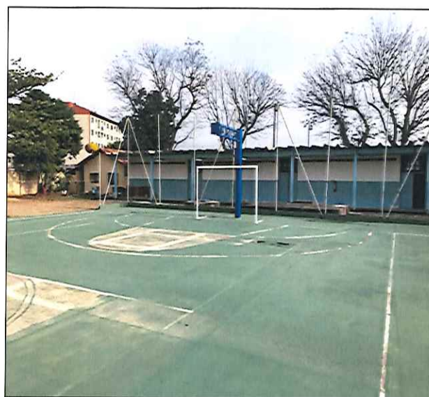
FOTO 10: VISTA DA QUADRA POLIESPORTIVA DURANTE A EXECUÇÃO DO SERVIÇO. 03/09/2019 - 08:28
