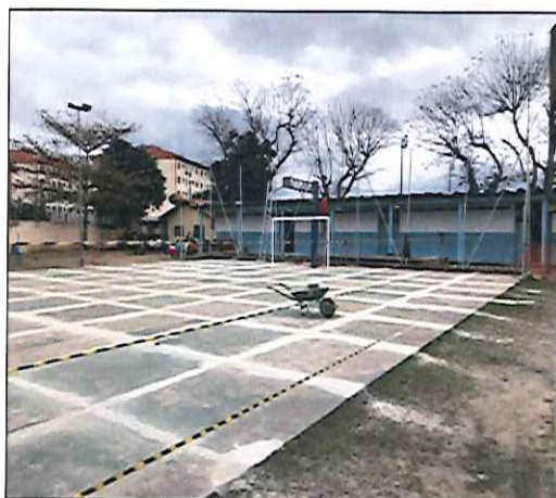
FOTO 09: VISTA DA QUADRA POLIESPORTIVA DURANTE A EXECUÇÃO DO SERVIÇO. 22/08/2019 - 13:26
