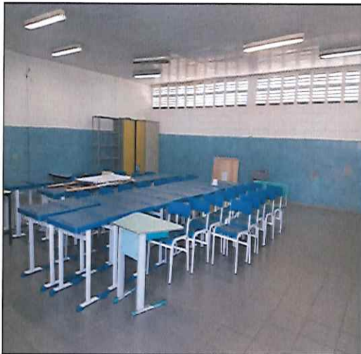
FOTO 03: VISTA DE SALA DE AULA ANTES DA EXECUÇÃO DOS SERVIÇOS. 17/07/2019 - 12:15
