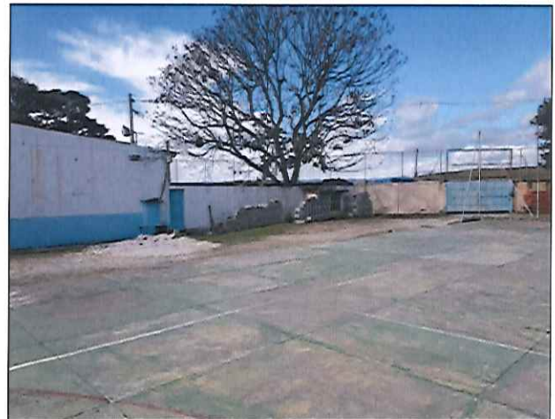
FOTO 04: VISTA DA QUADRA POLIESPORTIVA ANTES DA EXECUÇÃO DOS SERVIÇOS. 17/07/2019 - 12:23
