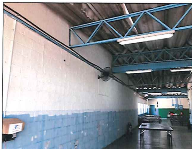
FOTO 12: VISTA DO REFEITÓRIO DURANTE A EXECUÇÃO DOS SERVIÇOS. 18/09/2019 - 10:40
