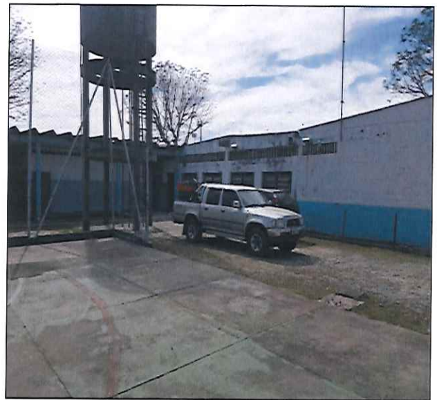
FOTO 06: VISTA DA CAIXA D'ÁGUA ANTES DA EXECUÇÃO DO SERVIÇO. 17/07/2019 - 12:23.
