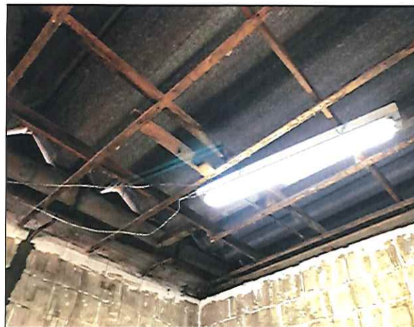
FOTO 20: VISTA DA COZINHA DURANTE A EXECUÇÃO DOS SERVIÇOS. 22/10/2019 - 14:56
