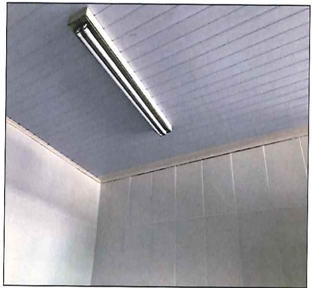
FOTO 26: VISTA DA COZINHA APÓS A EXECUÇÃO DO SERVIÇO. 17/12/2019 - 09:26
