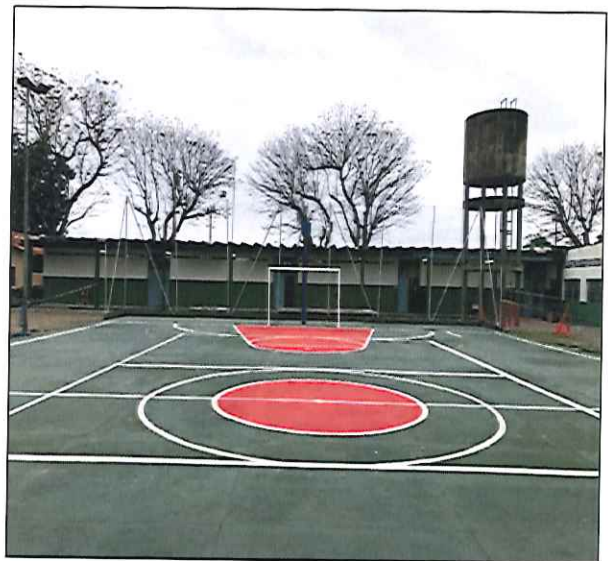
FOTO 14: VISTA DA QUADRA POLIESPORTIVA APÓS A EXECUÇÃO DO SERVIÇO. 23/09/2019 - 16:10
