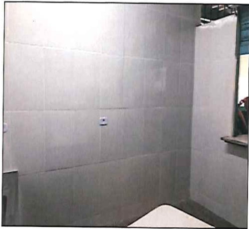
FOTO 25: VISTA DA COZINHA APÓS A EXECUÇÃO DO SERVIÇO. 12/11/2019 - 09:49
