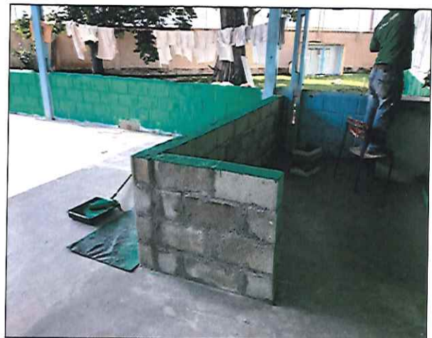
FOTO 16: VISTA DE MURETA DE ALVENARIA DURANTE A EXECUÇÃO DOS SERVIÇOS. 10/10/2019 - 09:11
