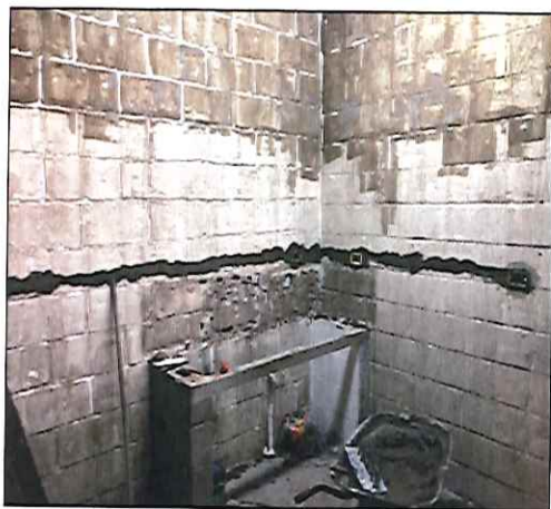
FOTO 21: VISTA DA COZINHA DURANTE A EXECUÇÃO DO SERVIÇO. 22/10/2019 - 14:56
