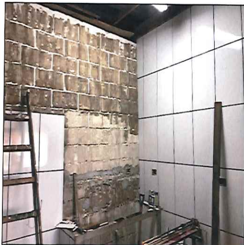
FOTO 23: VISTA DA COZINHA DURANTE A EXECUÇÃO DO SERVIÇO. 31/10/2019 - 15:28
