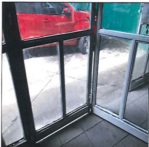
FOTO 19: VISTA DE PORTA DE ENTRADA ANTES DA EXECUÇÃO DO SERVIÇO. 10/10/2019 - 09:48
