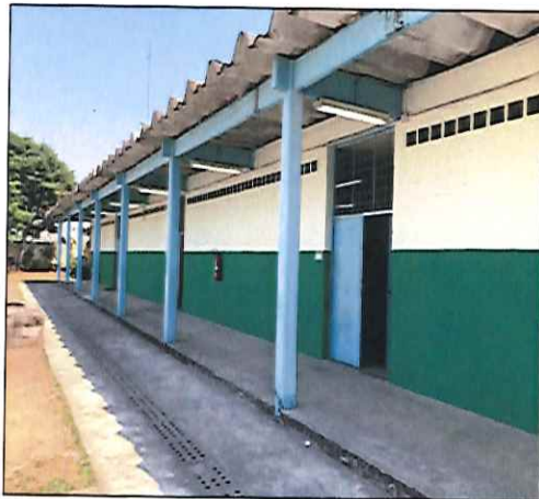
FOTO 13: VISTA DAS SALAS DE AULA À ESQUERDA DO PRÉDIO DURANTE A EXECUÇÃO DO SERVIÇO. 18/09/2019 - 10:38
