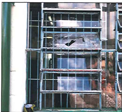
FOTO 17: VISTA DE JANELA DO REFEITÓRIO ANTES DA EXECUÇÃO DO SERVIÇO. 10/10/2019 - 09:45
